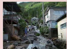
土石流が発生した松原地区
