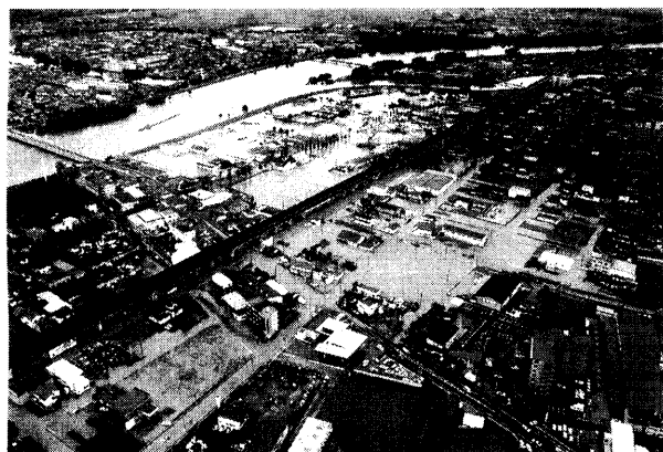
写真-1 福島県郡山市の浸水被害状況
