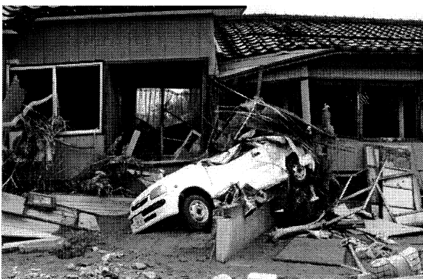
写真-1 刈谷田川(破堤点付近)
