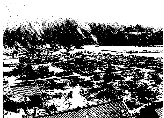
写真2 昭和19年東南海地震直後の錦地区
