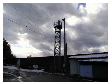
【写真-09】 津波監視カメラ
