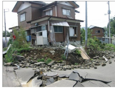
【写真-06】 2004年新潟県中越地震による被害
