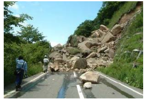
【写真-14】 2008年岩手・宮城内陸地震時の被災状況他
