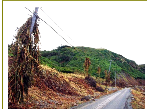
【写真-05】 1993年北海道南西沖地震による奥尻島の被害
