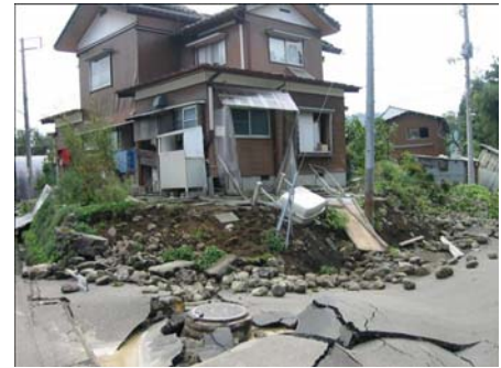
【写真-06】 2004年新潟県中越地震による被害
