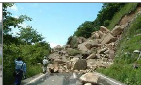
【写真-06】[5枚] 2008年 岩手・宮城内陸地震時の被災状況
