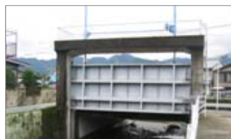
【写真-08】[9枚] 横引ゲート、水門、防潮堤
