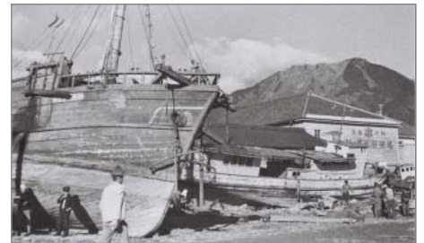
【写真-01】[17枚] 1944年 昭和東南海地震津波による尾鷲市の被害
