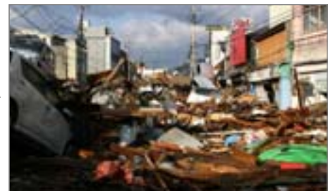
【写真-07】[17枚] 2011年 東日本大震災による釜石市の被害
