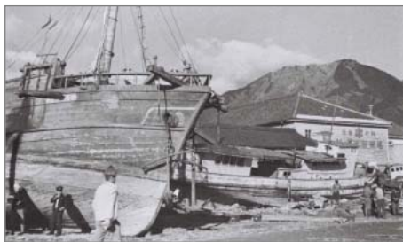
【写真-01】 [17枚] 1944年 昭和東南海地震津波による尾鷲市の被害
