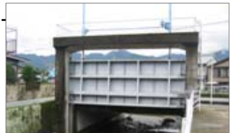
【写真-08】 [9枚] 横引ゲート、水門、防波堤
