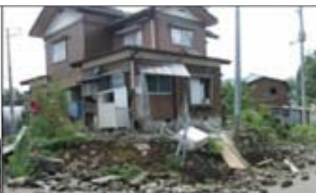
【写真-04】 [11枚] 2004年 新潟県中越地震による被害
