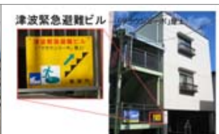
【写真-12】 [1枚] 津波緊急避難ビルの例
