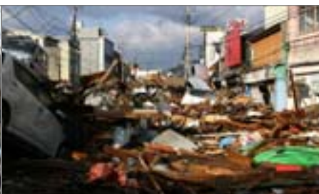
【写真-07】 [17枚] 2011年 東日本大震災による釜石市の被害
