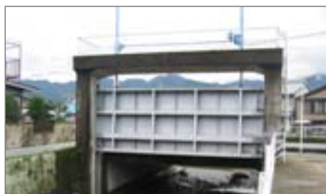
【写真-08】 [9枚] 横引ゲート、水門、防波堤
