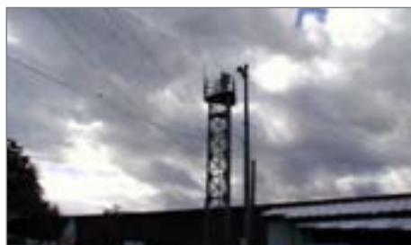
【写真-09】 [4枚] 津波監視カメラ
