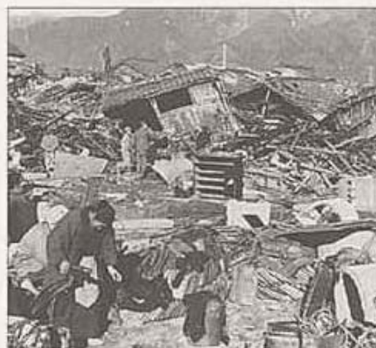
破壊された家屋
