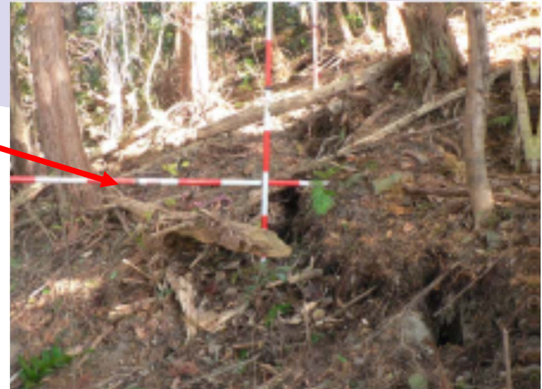
ひび割れ、段差ができる
