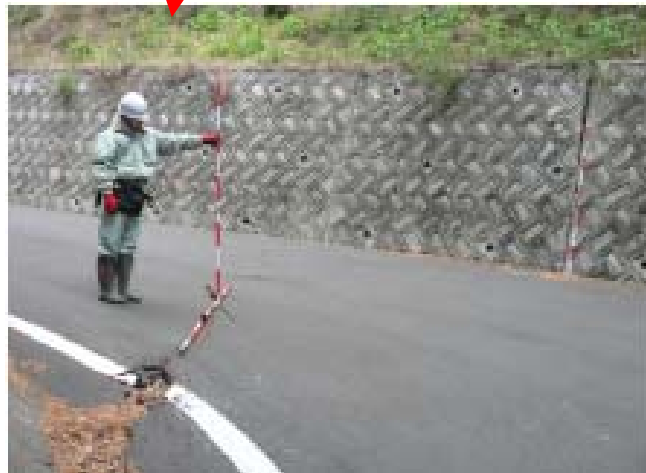
道路にひび割れ
